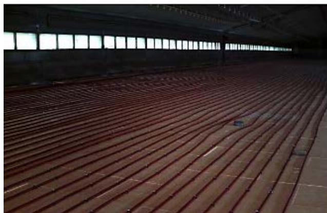
Photo : exemple installation de plancher chauffant (ITAVI)
