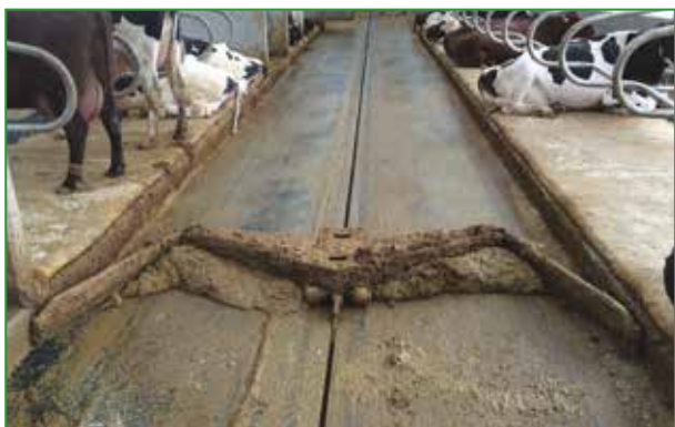
Photo 30 : Couloir en asphalté avec pente en V
