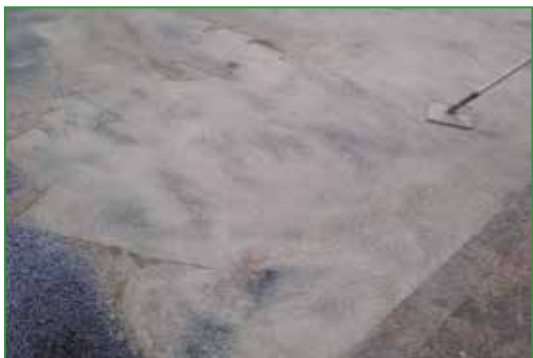
Photo 13 : Pour donner de l'adhérence en début de vie du revêtement, mise en place d'un sablon à refus sur l'asphalte encore chaud.
