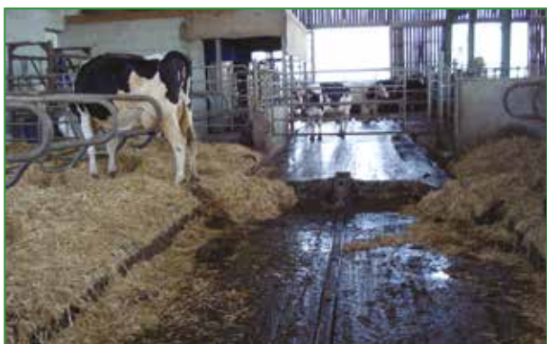
Photo 26 : Couloir raclé asphalte devant l'espace robot et entre logettes
