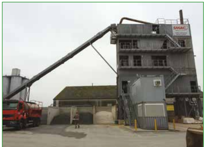
Photo 1 : Les centrales de fabrication de l'asphalte sont peu nombreuses sur le territoire (sur la photo celle de la SMAC à Rennes pour la Bretagne et les Pays de la Loire) mais grâce aux camions calorifugés et chauffants, le transport de l'asphalte à 200°C peut se faire sur de longues distances
