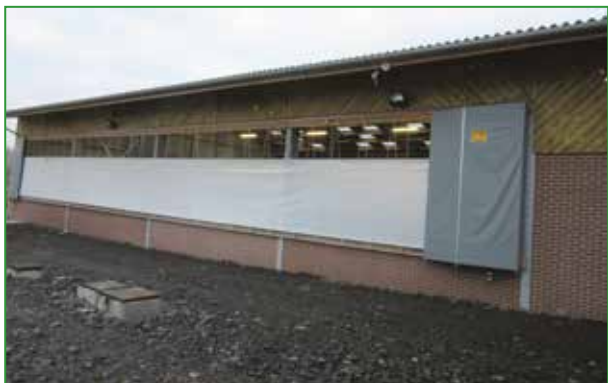
Photo 28 : Bâtiment très bien ventilé avec brise-vent amovible sur les longs pans
