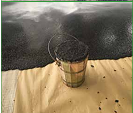
Photos 6 et 7 : L'utilisation de seaux en bois vient du fait que l'asphalte ne colle pas à l'intérieur et que le bois diminue le risque de brûlures des compagnons
