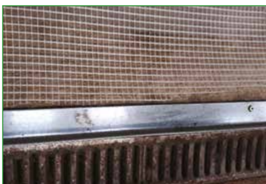
Photo 4 : Dans cet exemple, la grille est déroulée devant le caniveau d'évacuation sur le papier kraft et maintenue par une cornière.
