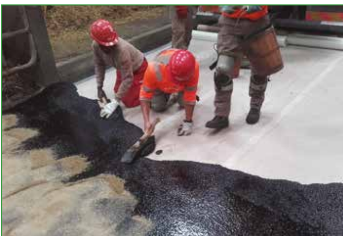
Photo 10 : Le porteur de seaux amène l'asphalte à proximité de l'applicateur et le répand sous forme d'une bande sur toute la coulée d'application
