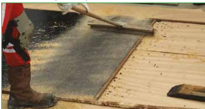
Photo 15 : Puis, répartition/homogénéisation du sable en surface au balai et élimination de l'excédent. Après balayage, poursuite de l'épandage sur la nouvelle partie d'asphalte dernièrement coulé.
