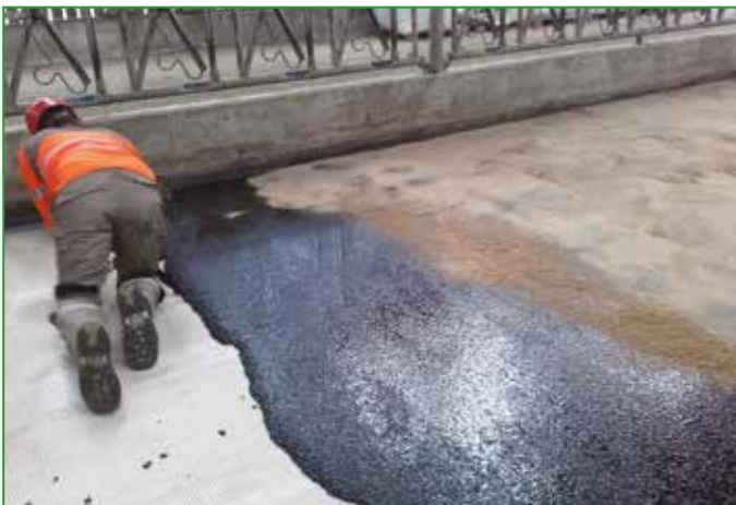
Photo 11 : Asphalte en cours de coulage : apport d'asphalte dans des seaux en bois.
