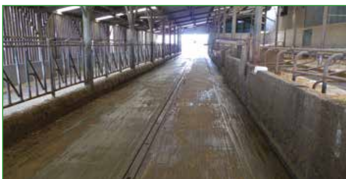
Photo 19 : Couloir d'alimentation, raclage de lisier
