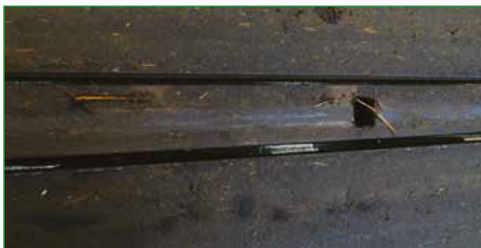
Photo 21 : Les racleurs étant aussi usagés, ils ont été remplacés lors de la rénovation des sols. Après sciage de l'ancien béton, les rails ont été installés et surélevés de la hauteur de la couche d'asphalte. Les bordures ont donc servi de coffrage pour les 2 cm d'asphalte.
