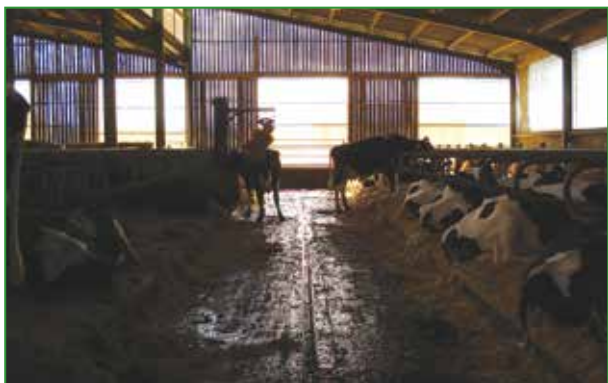
Photo 24 : Vue intérieure du bâtiment, couloir asphalte entre logettes
