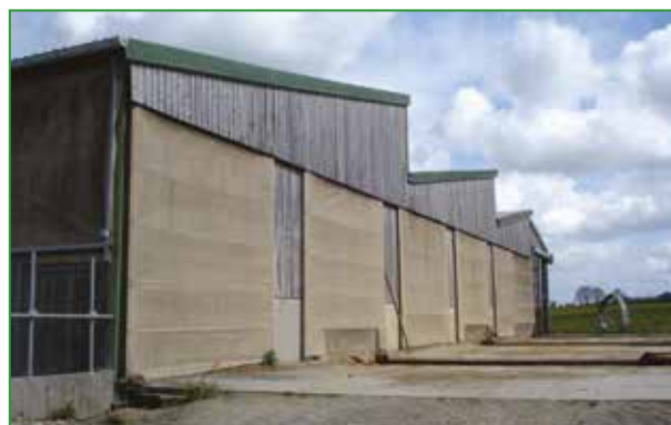
Photo 27 : Vue extérieure du bâtiment, toiture en sheds
