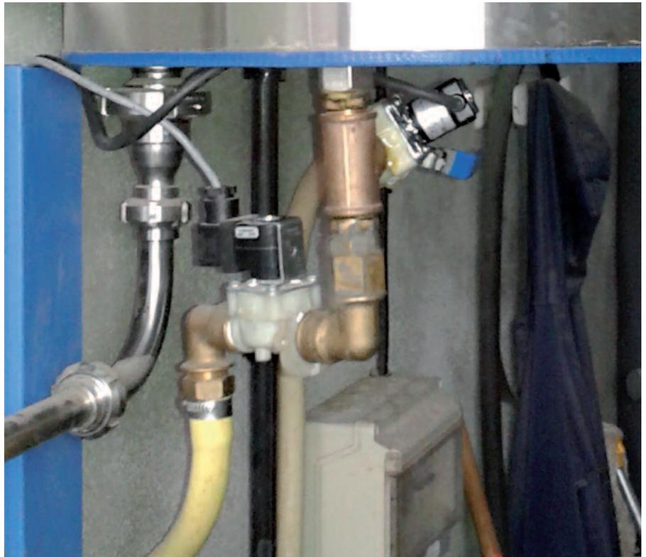
*Dispositif de purge automatique sur un pré-refroidisseur.*
