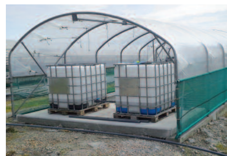
La cuve tampon sécurise l'installation de traitements des effluents phytos : ici des cuves PEHD se déversent par gravité dans un phytobac.
