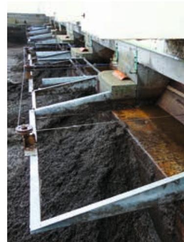
Système de raclage des effluents
