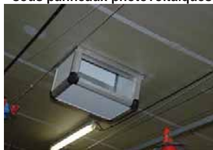
Poulailler avec récupération de chaleur sous panneaux photovoltaïques
