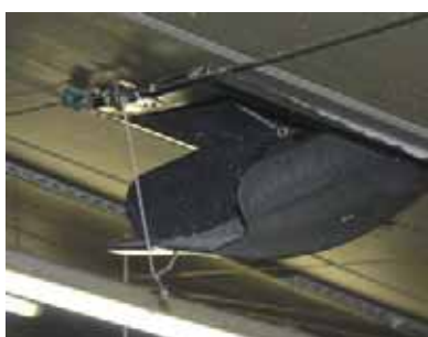
Trappe d'entrée d'air en sous toiture
