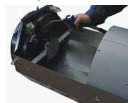
Soufflage d'un aérotherme
