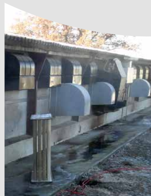
ERC installé sur un long pan avec aire bétonnée
