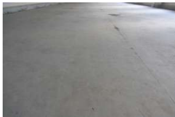
Les joints de dilatation présents dans 61% des cas
