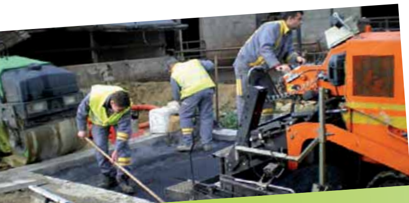
Coulage d'une dalle avec de l'enrobé.
